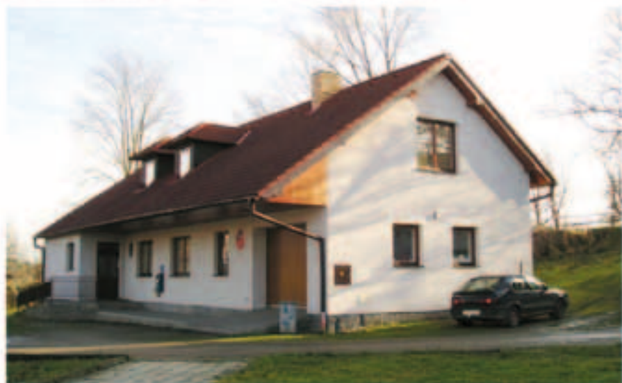
Víceúčelová budova obecního úřadu v Rozseči.
