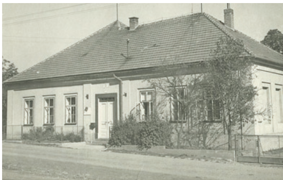
Původní vzhled školní budovy.
