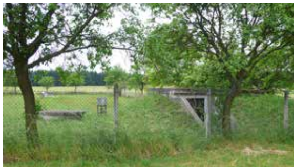
Studny a vodárna.
