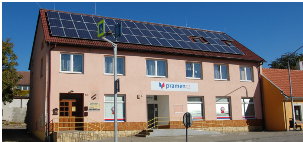
Dům čp. 54 v současnosti, po dvou desetiletích od přestavby pro účely prodejny potravin. | Foto: autor
