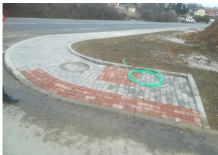
Rekonstrukce ulice Rajhradská – Jihlavská. Foto: Archiv autora
