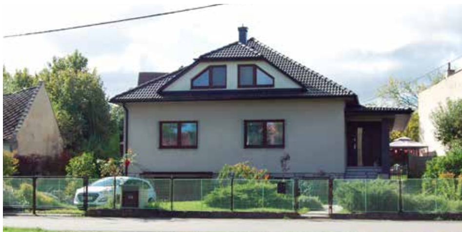
Dům čp. 180 a za ním skrytý dům čp. 172 v současnosti. | Foto: autor
